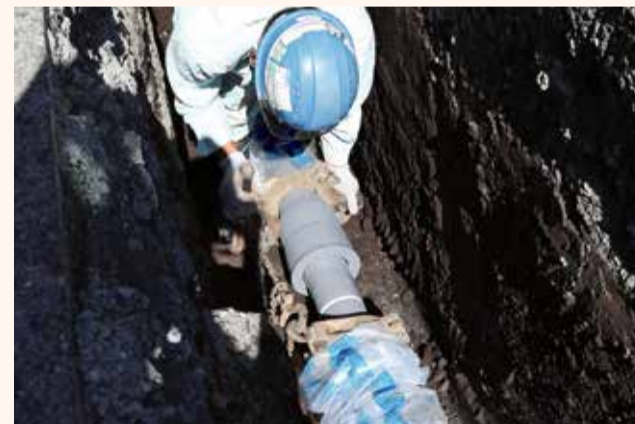
水道管の更新工事で管を接続する様子
