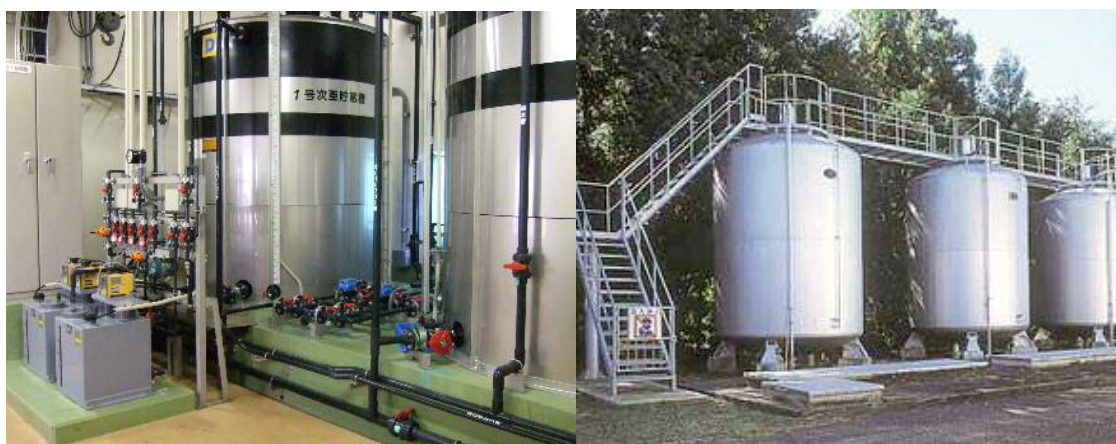
次亜塩素素注入設備
