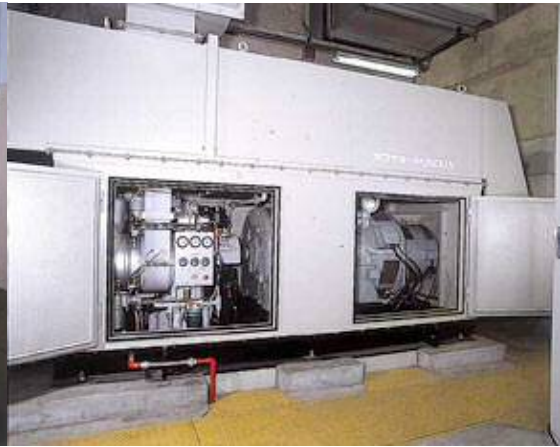
自家発電設備
