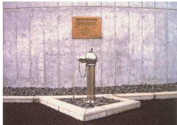
災害用応急給水栓
