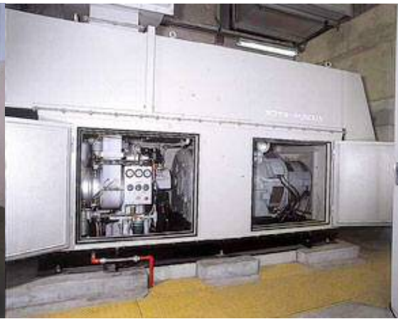
自家発電設備
