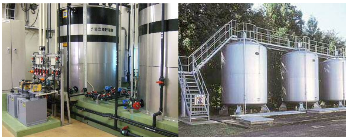
次亜塩素素注入設備
