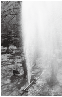
①吹き上がる漏水
