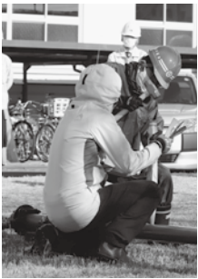
③ハンマーで打込みしっかり止水
