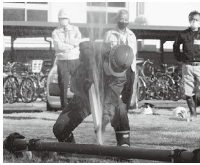
②漏水箇所木材を差込む
