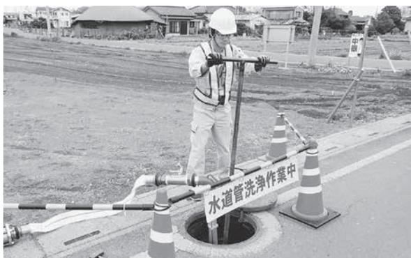
作業方法は、消火栓などからの夜間排水作業により、水道管内部を洗浄します。
